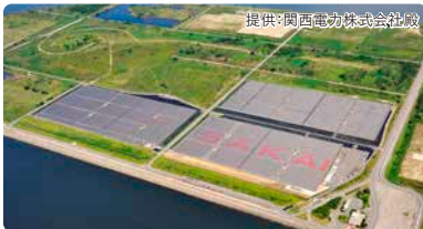
堺太陽光発電所
